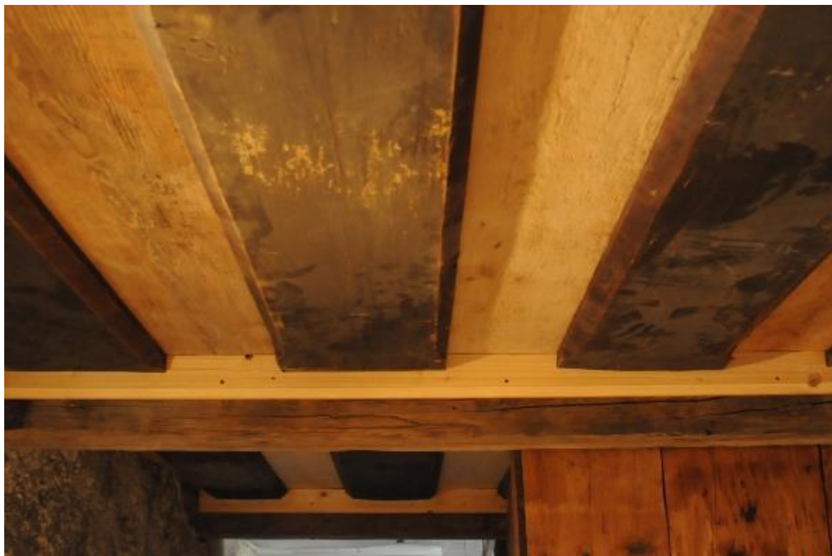
Obr. Z.1. Opravený strop v Českom Krumlove.
