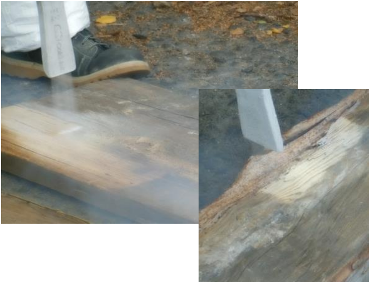
Obr. 11.1 a 11. 2. Tryskanie povrchu dreva granulami \text{CO}_2 .
