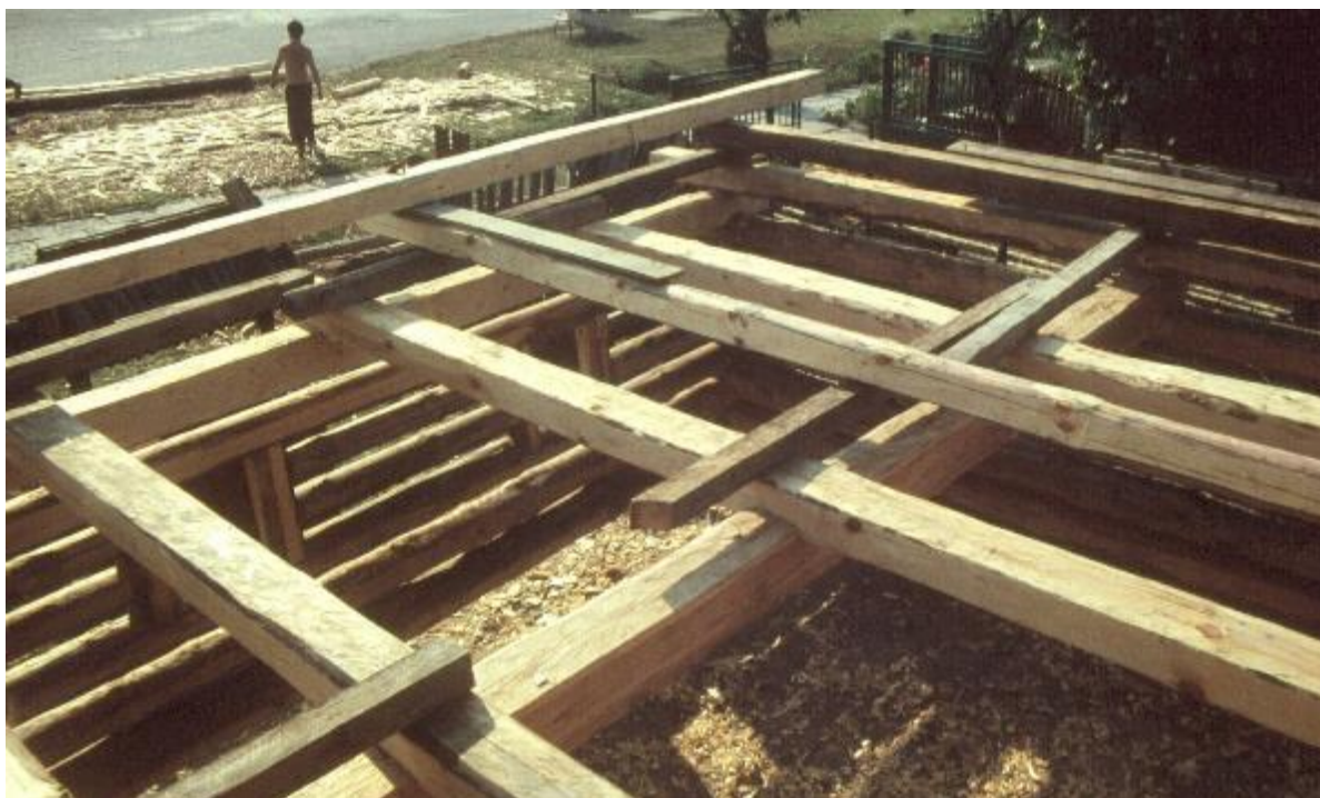
Obr. 10.4. Skladba rekonštruovaného dreveného stropu. drevenice
