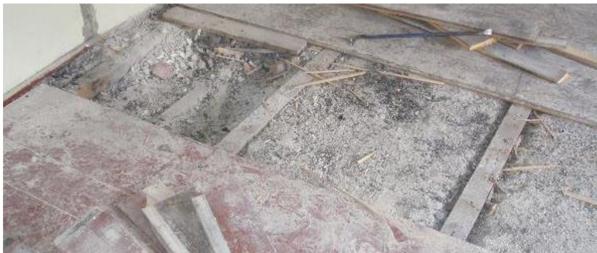
Obr. 10..7. Odhalený podlahový zásyp zo zmesi stavebnej sutiny a škvary.
