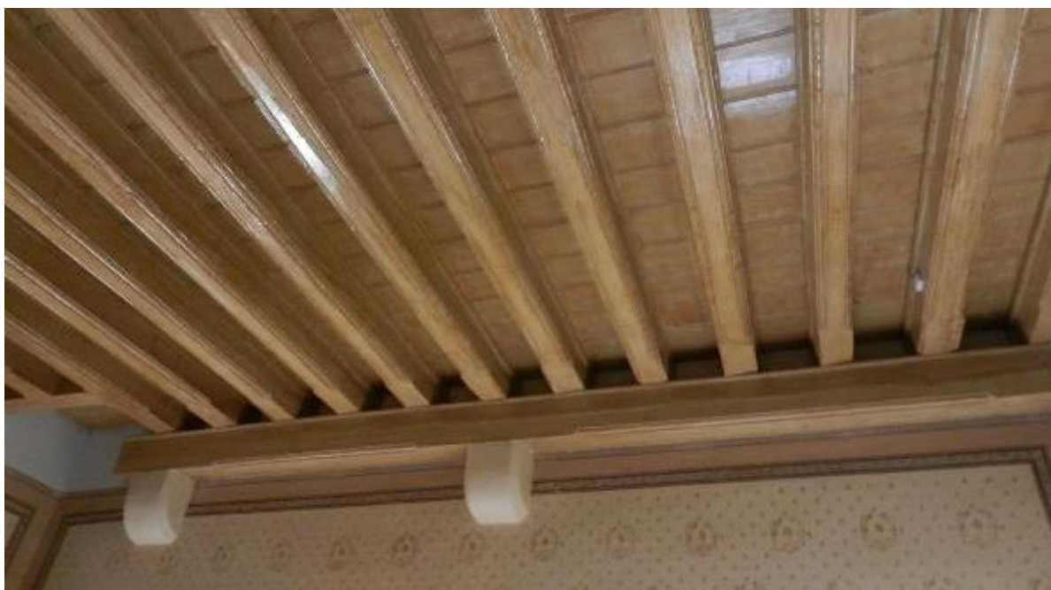
Obr. 4.6. 4.7. Dva príklady uloženia stropných tráv na konzolu v hrade Krásna Hôrka. Tento strop našťastie nebol poškodený požiarom. Fotografie sú z rokov 2000 a 2016.
