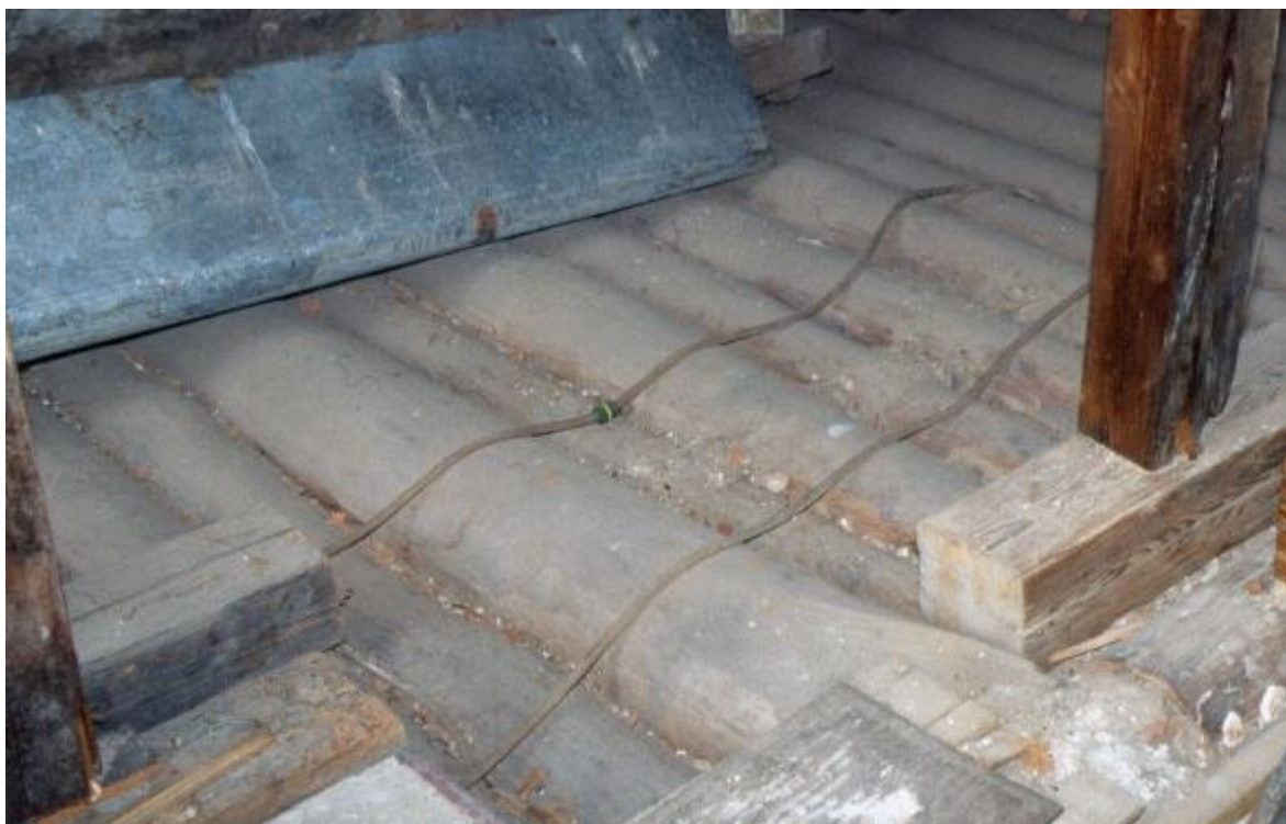
Obr. 3.3 Pohľad na povalový strop z vrchu.
