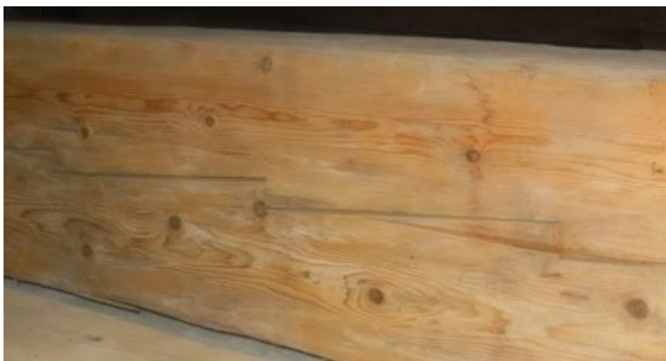
Obr. 3.44. Príklad zazubenia dvoch trámov do seba v barokovom divadle v zámku Český Krumlov.
