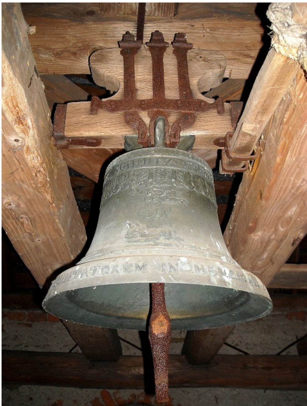
7. Šarbov (okr. Svidník), gr. kat. kostol: zvon, 1843, Pavol Anton Schmitz v Prešove Autentický stav zvona s pôvodným príslušenstvom z čias vzniku zvona: neotáčaný zvon, dubová hlava z masívu, zvon pripevnený tromi párami kovaných závesov s prepásaním a sponami, osadený v klzných ložiskách do drevenej trámovej zvonovej stolice v podlaží veže kostola; kované srdce zvona má tradičný tvar s hruškovou päsťou, k hlave je pripevnená drevená páka s lanom na tradičné ručné zvonenie praktizované do súčasnosti. Príslušenstvo zvona si vyžaduje základnú starostlivosť a pravidelnú bežnú údržbu.
