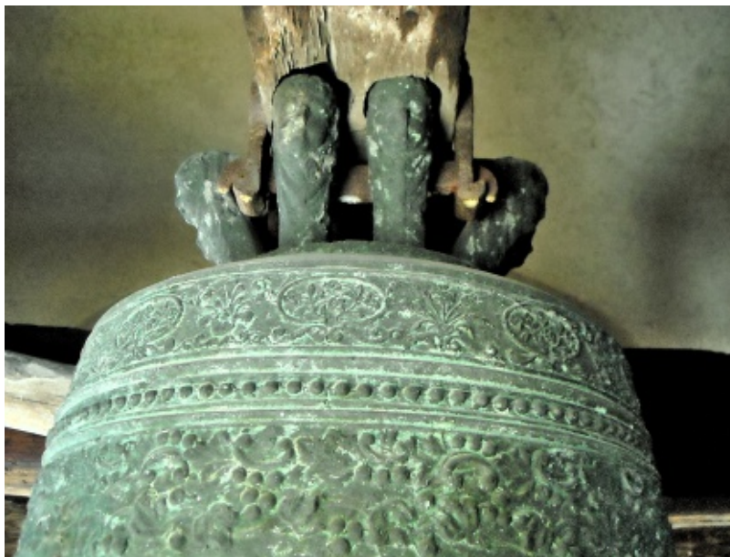
33. Nová Lesná (okr. Poprad), ev. a. v. kostol: zvon, 1857, Andrej Schaudt v Pešti Detail utiahnutia pôvodnej osemramennej antropomorfnej koruny zvona, ktorá je zadlabaná do pôvodnej subtilnej drevenej hlavy. Koruna by mala byť v drevenej hlave vždy pevne utiahnutá – zasadená z akustických dôvodov a z hľadiska väčšej stability zvona.
