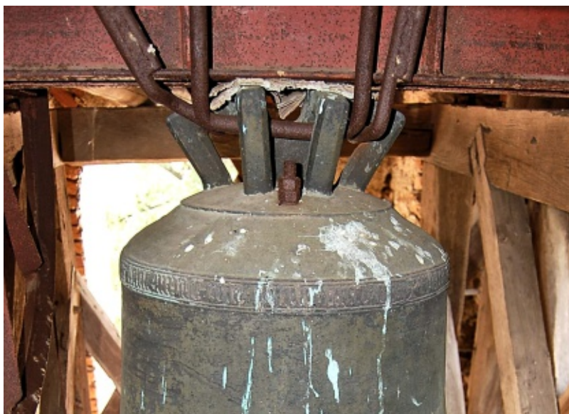
34. Ozdín (okr. Poltár), ev. a. v. kostol: zvon z 15./16. storočia, neznámy lejár. Foto Ján Čáni, KPÚ Trnava Negatívny sekundárny zásah prevŕtaním príklopu zvona (podkorunnej dosky) na prevlečenie skrutiek na upevnenie závesu srdca. Korózia šíriaca sa do hmoty zvona hrozí vznikom trhliny v čepci.
