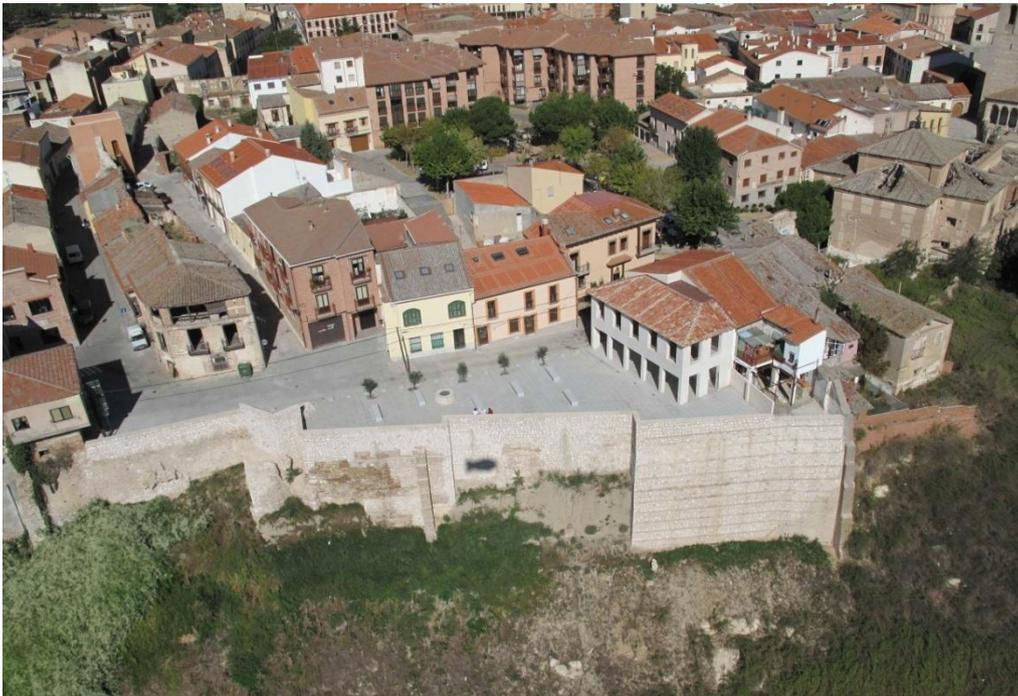
De nuevo graves problemas estructurales derivados de los bordes hacia el río son el motor de estas intervenciones de recuperación de murallas derrumbadas y ocasión para recuperar espacios para el peatón y construir un edificio-mirador que tapa una medianera y cierra una plaza.
